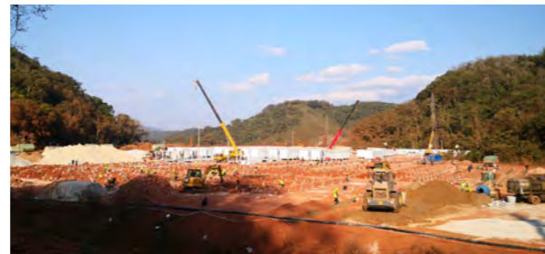
昆船集团建设方舱医院
